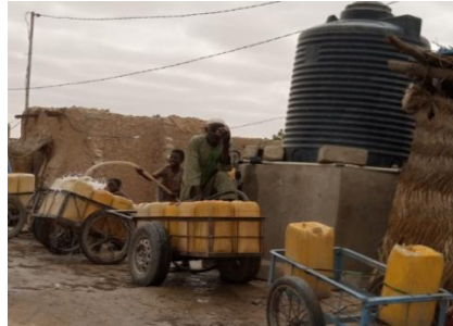
Photo N° 2 : Approvisionnement via un forage en zone centrale
